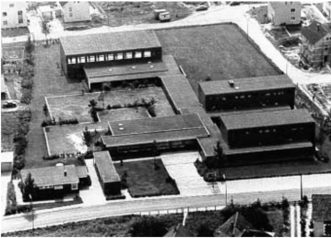
Die neue Schule: Die Grundschule Sundern hatte ab 1964 sechs Klassenzimmer, einen Werkraum und eine große Pausenhalle.
